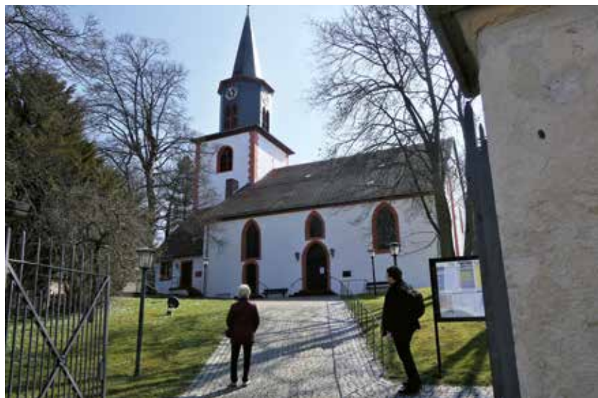
Evangelische Kirche St. Laurentius – Roman. Bau 1226 vollendet, Gotische Erweiterung um 1500
