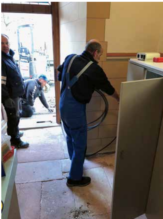
Herr Walter in Aktion beim Verlegen des Kabels in der Sakristei
