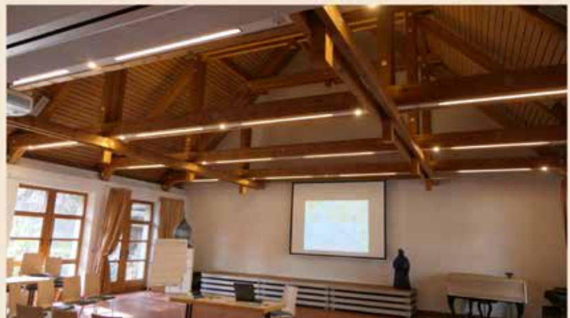
Innenanstrich und komplett erneuerte Saalbeleuchtung
